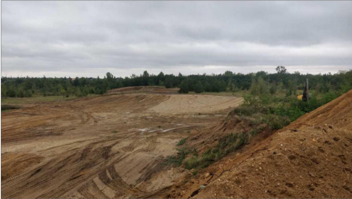
Abbildung 4: Herstellung der geforderten Böschungen (19.09.2022)
